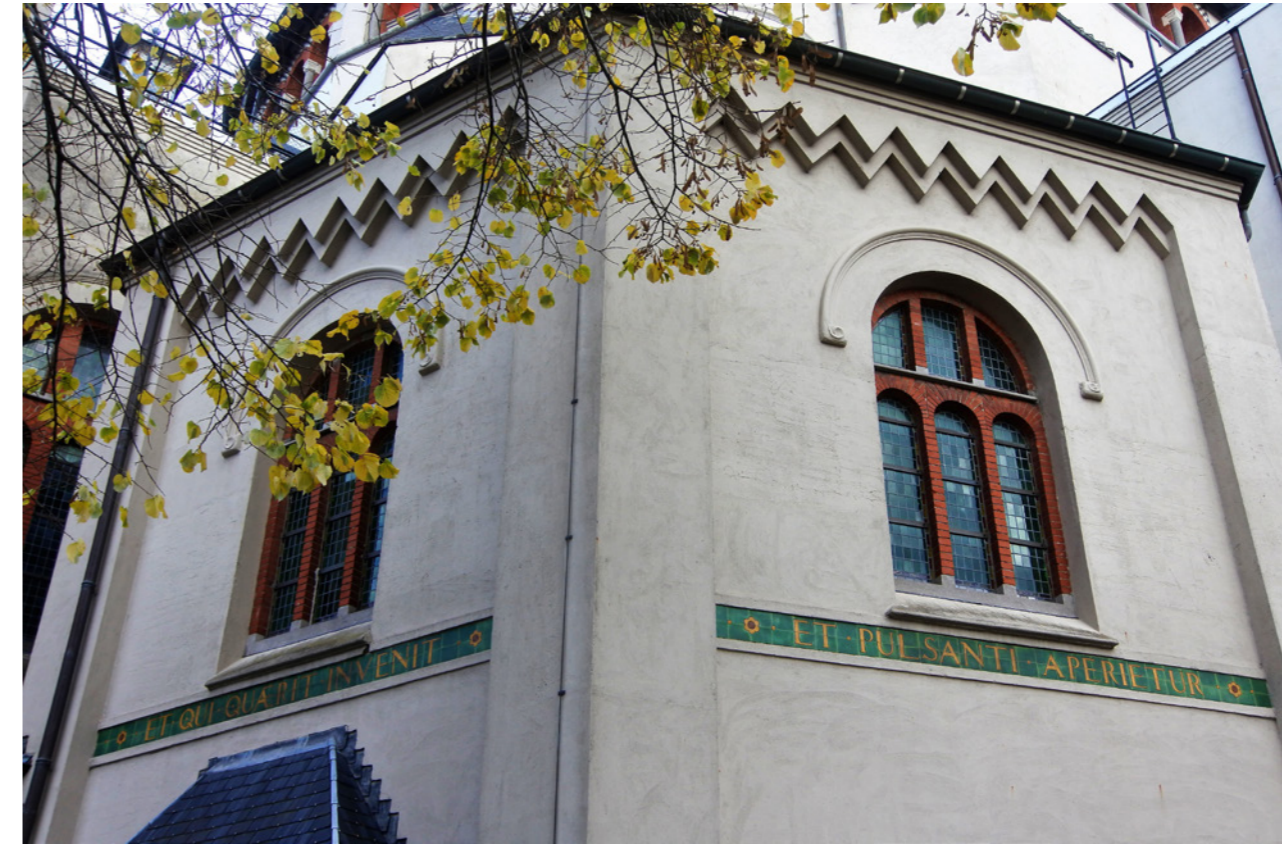
9.19 | Zijkapel, met boven een fries met zaagtanden, daaronder ramen met gemetselde traceringen en tekstbanden van keramische tegels.
